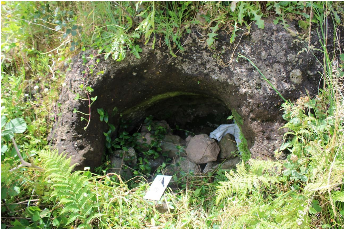
Fig 10 – Abertura escavada na rocha
