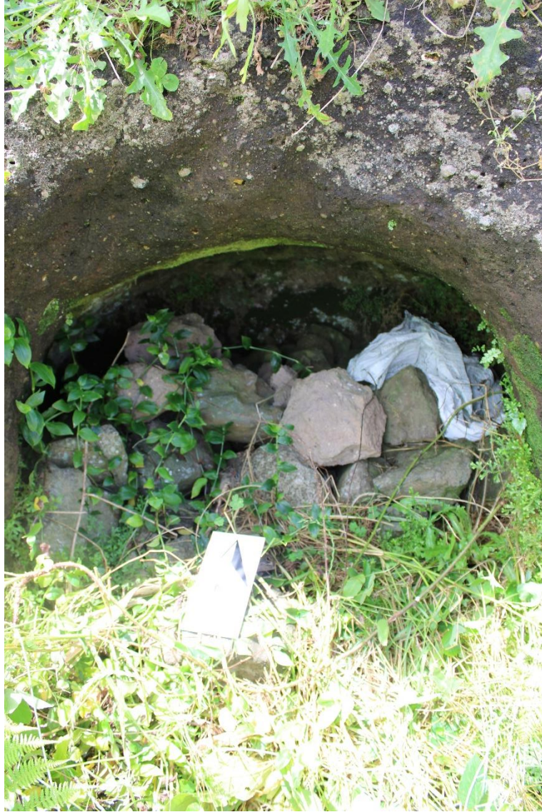
Fig. 11 – Pormenor do material de entulho de suposto abrigo.
