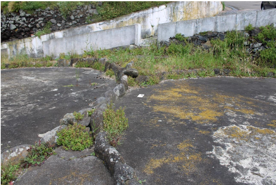
Fig. 5 – Detalha do elemento de união entre as duas eiras.
